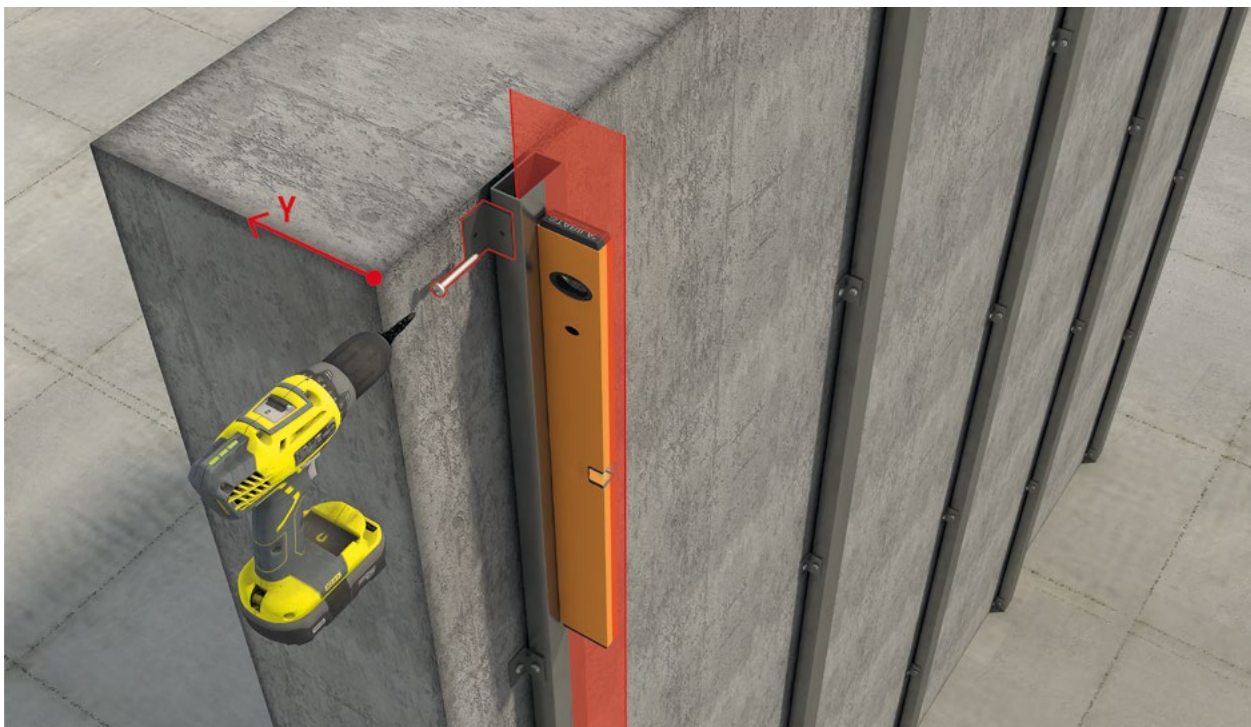
Αλφάδισμα κατακόρυφου φορέα στήριξης ως προς τον άξονα Υ Levelling of the vertical support beam along the Y-axis
