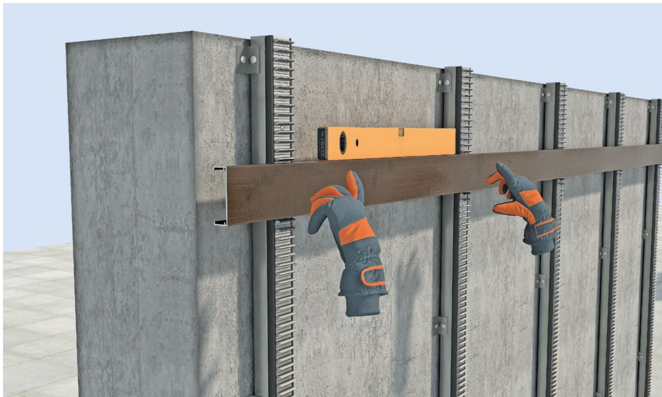
Τοποθέτηση πρώτου προφίλ επένδυσης με την βοήθεια αλφαδιού Installation of the first piece of the cladding profile with the help of a levelling tool
