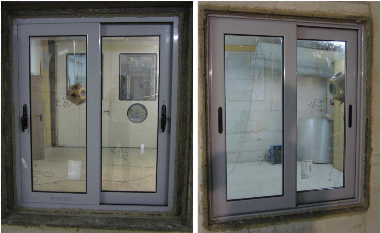
**Bild 1** Fotos des eingebauten Elementes, links vom Empfangsraum aus, rechts vom Senderraum aus, erstellt vom ift Schallschutzzentrum
